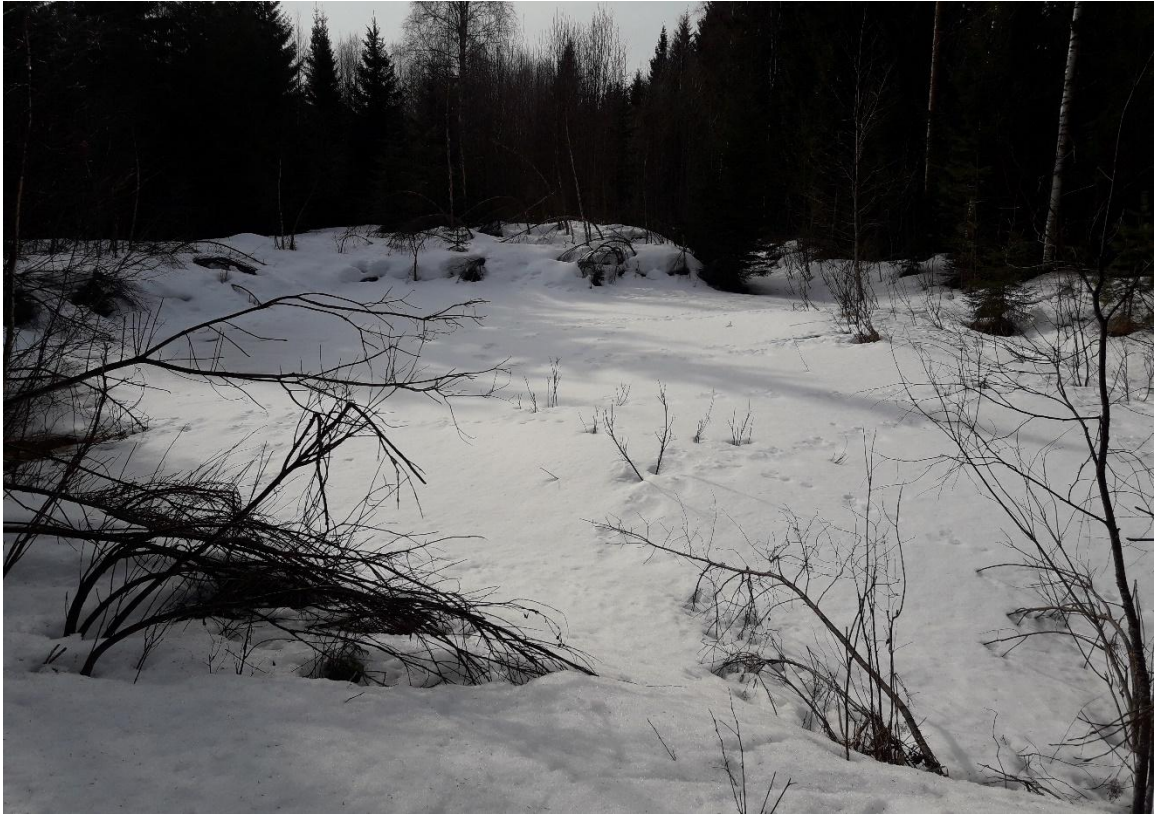
KUVA 4 Aiemmin tehty laskutusallas tyhjennetään kaivuutöiden yhteydessä.
