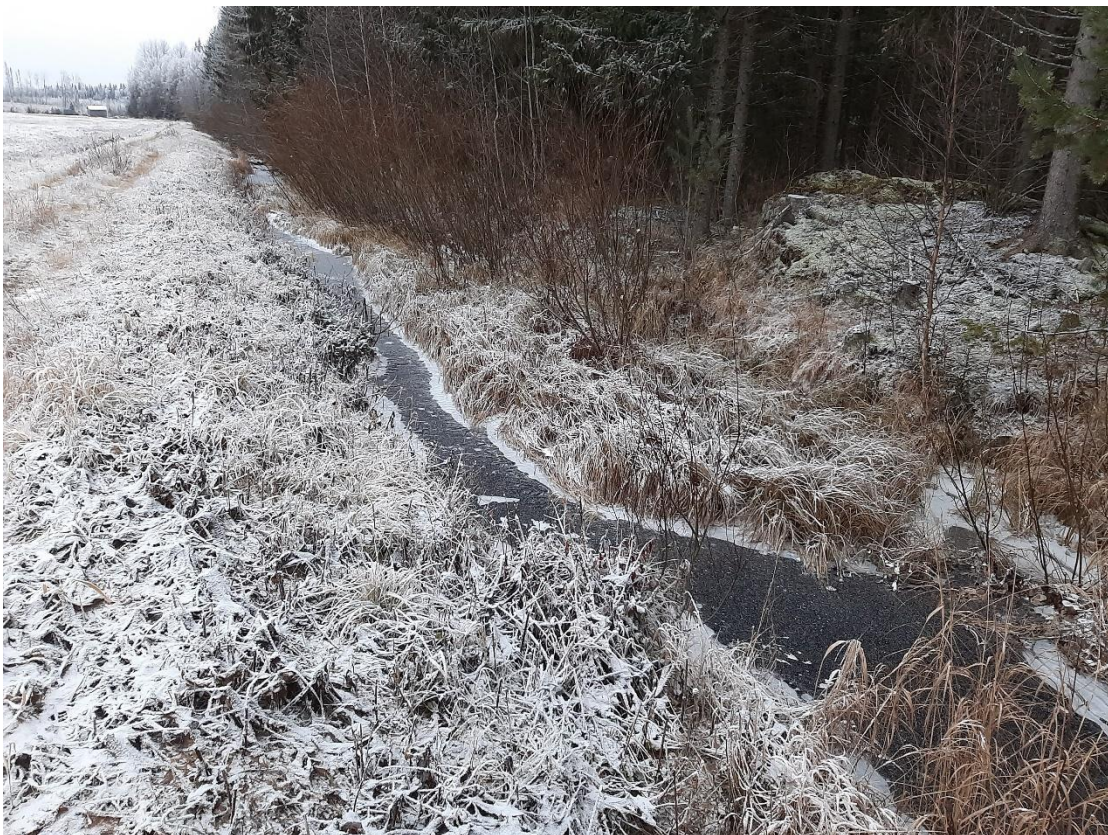
KUVA 9 Keskisen alueen maalaji on eroosioaltis, joten eritasouomaa ei kaiveta pellon kohdalle.
