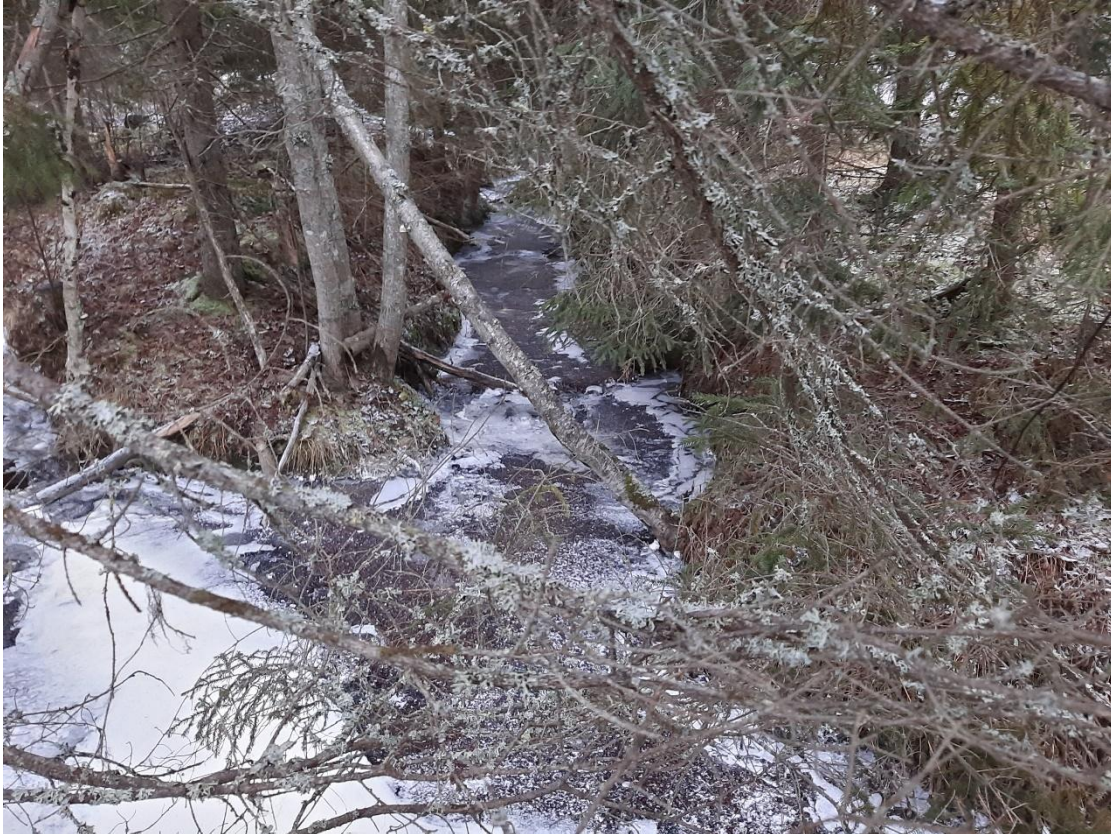
KUVA 11 Kulonevalta tulevan valtaojan ja Salmelanojan risteys on syöpynyt. Rakennetaan pohjapato ja uoman kiviverhoilu kalliolouhoksesta tai seulanpääkivistä.
