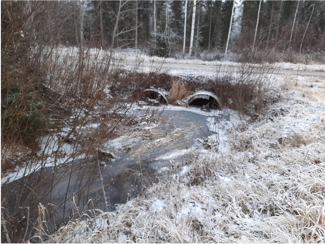
KUVA 8 Kuvassa metsätierummut (2x1400mm). Ojan tukkoisuus pitää vesipinnan korkealla.
