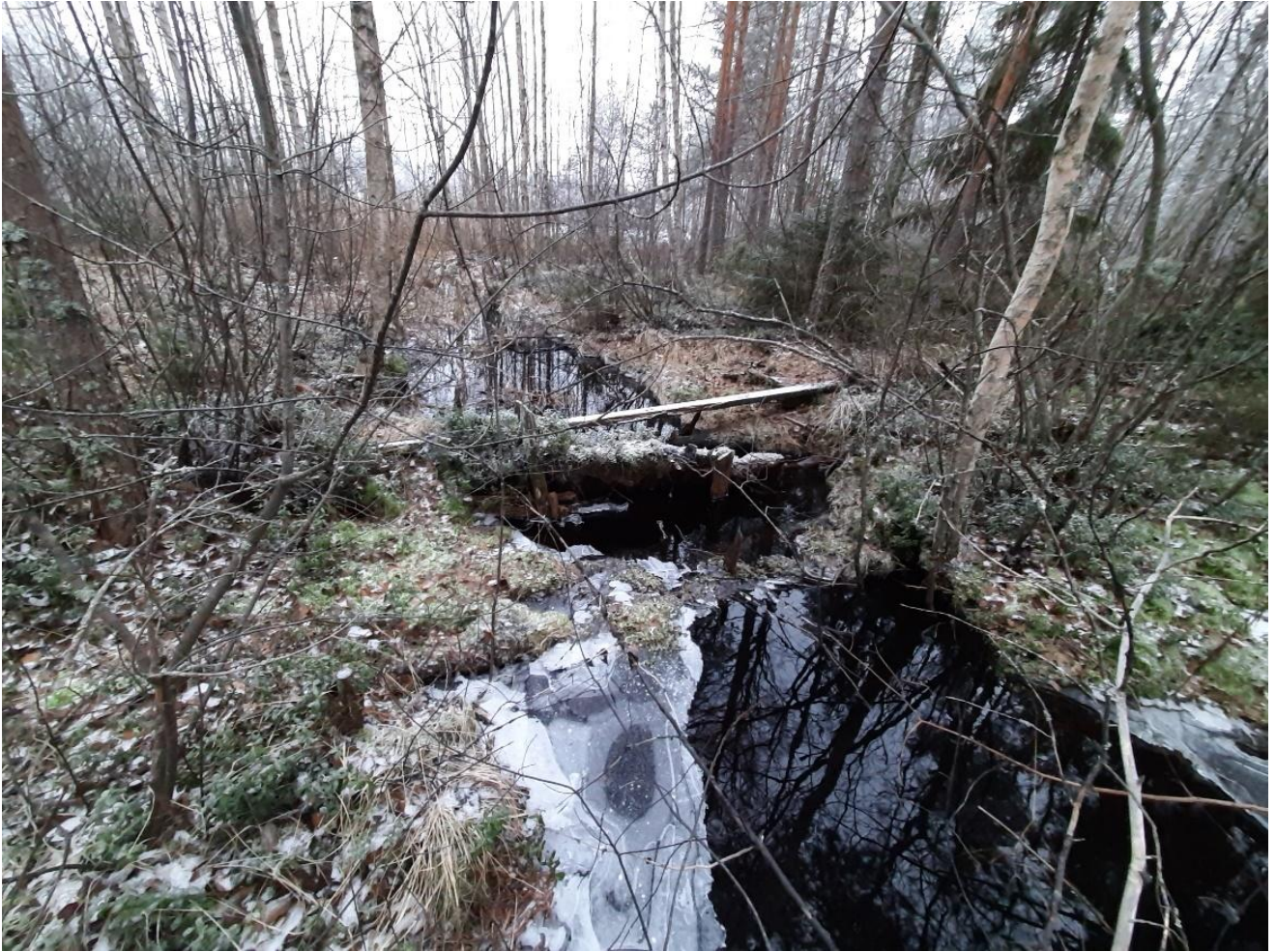
KUVA 2 Lammen alapuolella oleva puupato on huonossa kunnossa. Uudella pohjapadolla voidaan nostaa lammen vesipintaa. Lammen alapuolinen puro on perattu, mutta on vähitellen palautumassa luonnontilainen kaltaiseksi.
